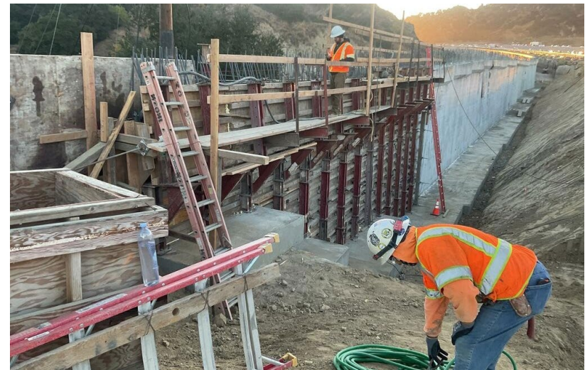
Retaining Wall 2460 Ready for Pour
