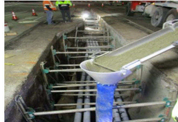
Conduit Encasing on Wilshire Blvd.
