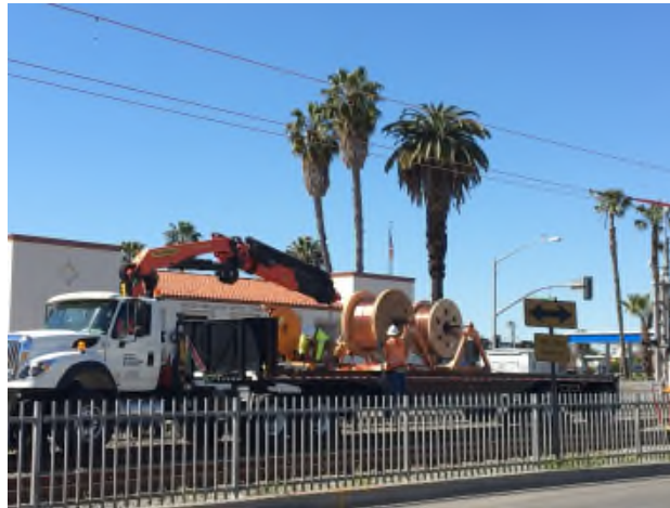
New OCS Wires
