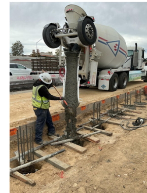
SW 2676 Pile Concrete Pour
