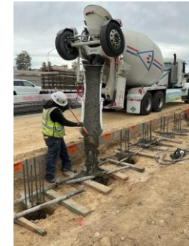
SW 2676 Pile Concrete Pour
